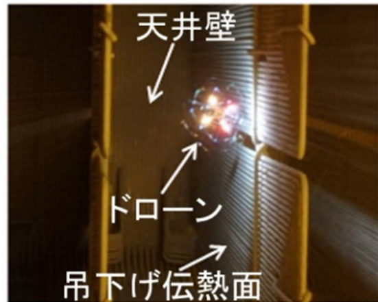
ボイラ内部の点検状況
