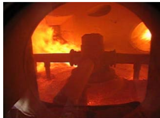
図 5 燃焼炉内の燃焼状況
